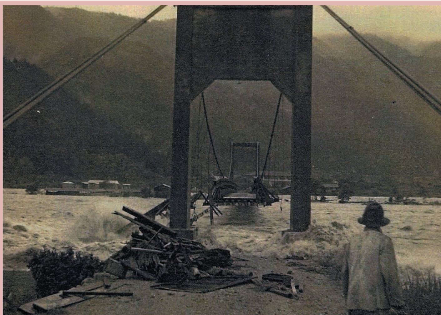
昭和33年7月飛騨川大洪水：この後さらに増水し、一瞬にしてワイヤーが切れた。
