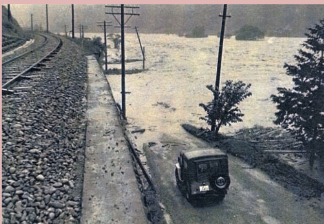
増水で寸断された旧国道と中呂地区 【昭和33年7月飛騨川大洪水】
