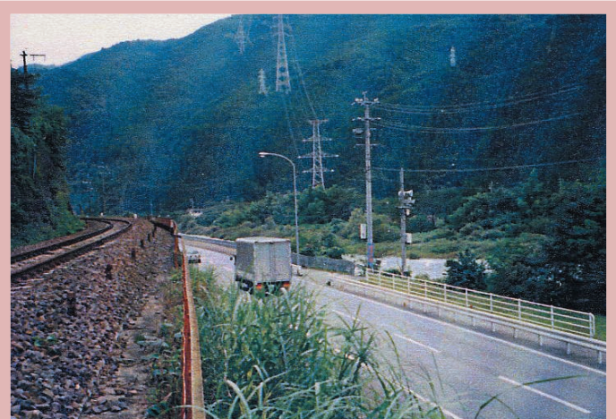
現在の国道41号と中呂地区
